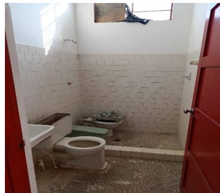
Fotografía 4: Las instalaciones sanitarias en mal estado.
