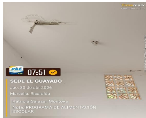
Fotografía 2: Cielo raso con presencia de humedad
