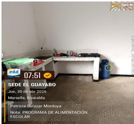
Fotografía 1: Mesón con grietas en mal estado
